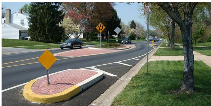
Figura 10: Șicană din borduri. Sursa: GDCL.
