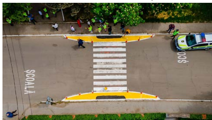
Figura 22: Intervenție de securizare a trecerii pietonale strada N. Testemițanu, Sîngerei, Republica Moldova. Sursa: ACM
