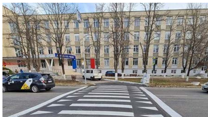
Figura 24: Trecere pietonală denivelată, str. Florilor, Chișinău. Sursa: Primăria Municipiului Chișinău.
