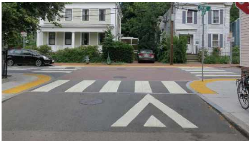
Figura 48: Exemplu de trecere de pietoni înălțată
