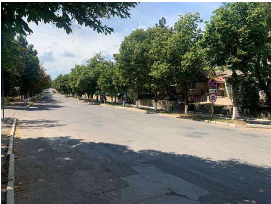
Figura 33: Limita de viteză de 30 km/h, strada Independenței, Sângerei.
