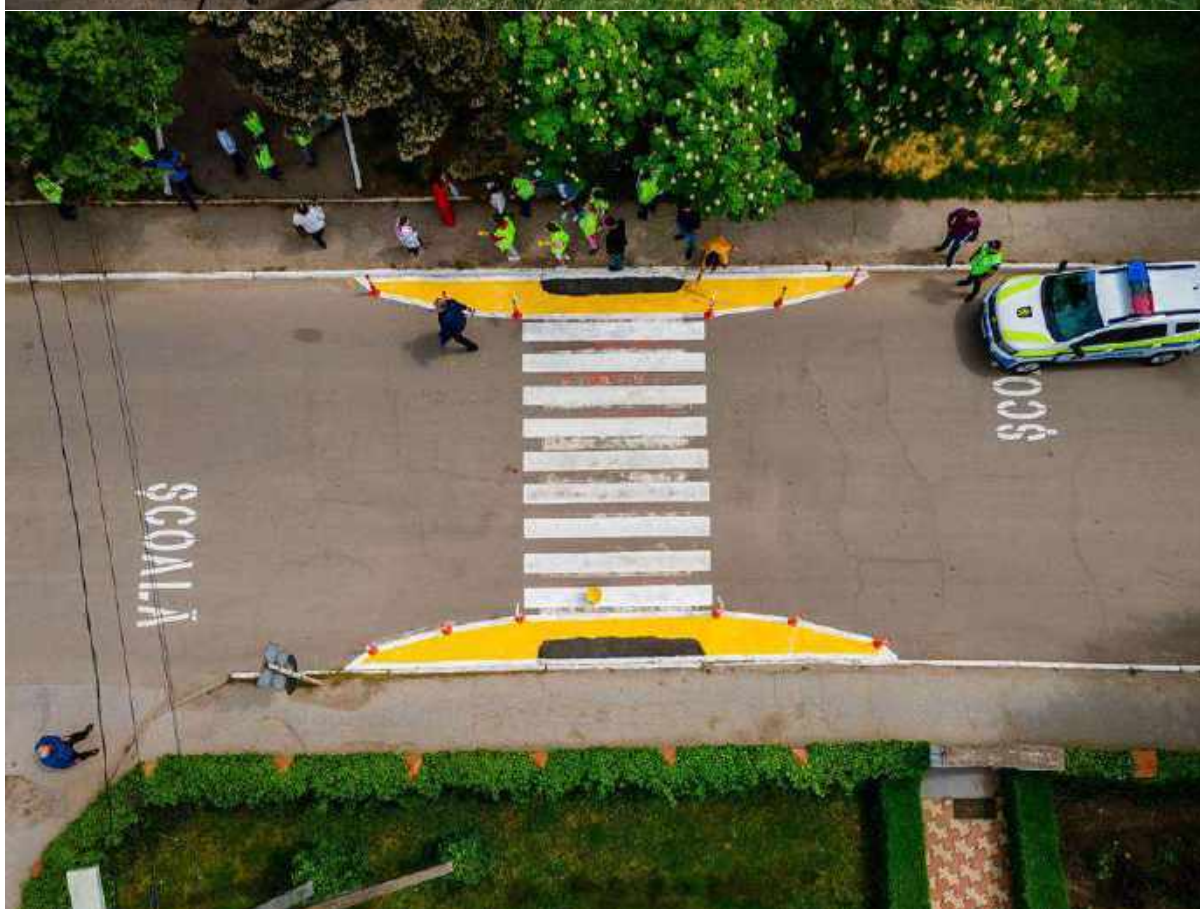
Figura 30: Trecere de pietoni în zona liceului „Dimitrie Cantemir”, Sângerei, după intervenție.
